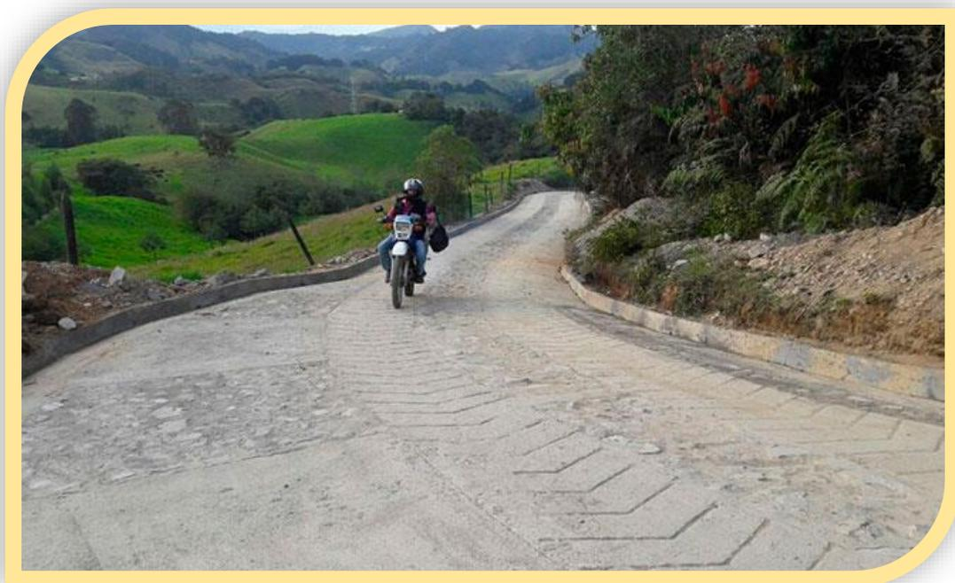
Nota. La imagen permite apreciar el mejoramiento de vías rurales utilizando el sistema de construcción denominado "Placa huella". Fuente: imagen tomada de Asenred.com, publicada en febrero 2 de 2017. Disponible en: <https://bit.ly/2Smj1NJ>).
